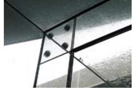
En overligger med boltsamlinger udgør en del af de rammer, der sikrer vindfangets stabilitet mod vindlast.
